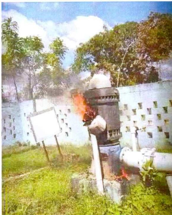
1- Motor de Eje Hueco de 250HP, Quemándose en El Pozo
