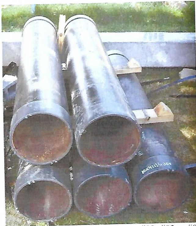
4- Columnas De Inicio Pozos #02, #03, y #04
